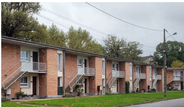
Patrimoine minier du quartier du Cérou à Carmaux (81) du bailleur Tarn Habitat.
